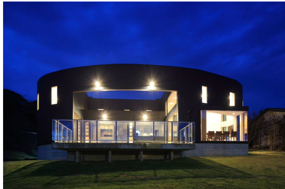
設計の補助と施工監理
